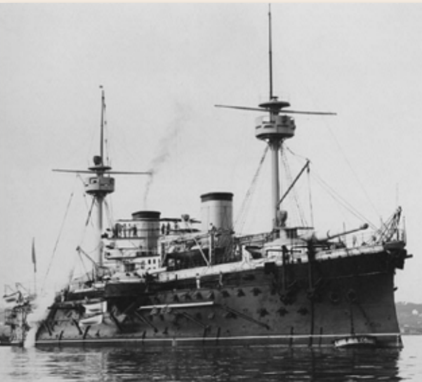
Acorazado "Pelayo" visto de amura. Puede verse la torre de proa, de 320 milímetros
