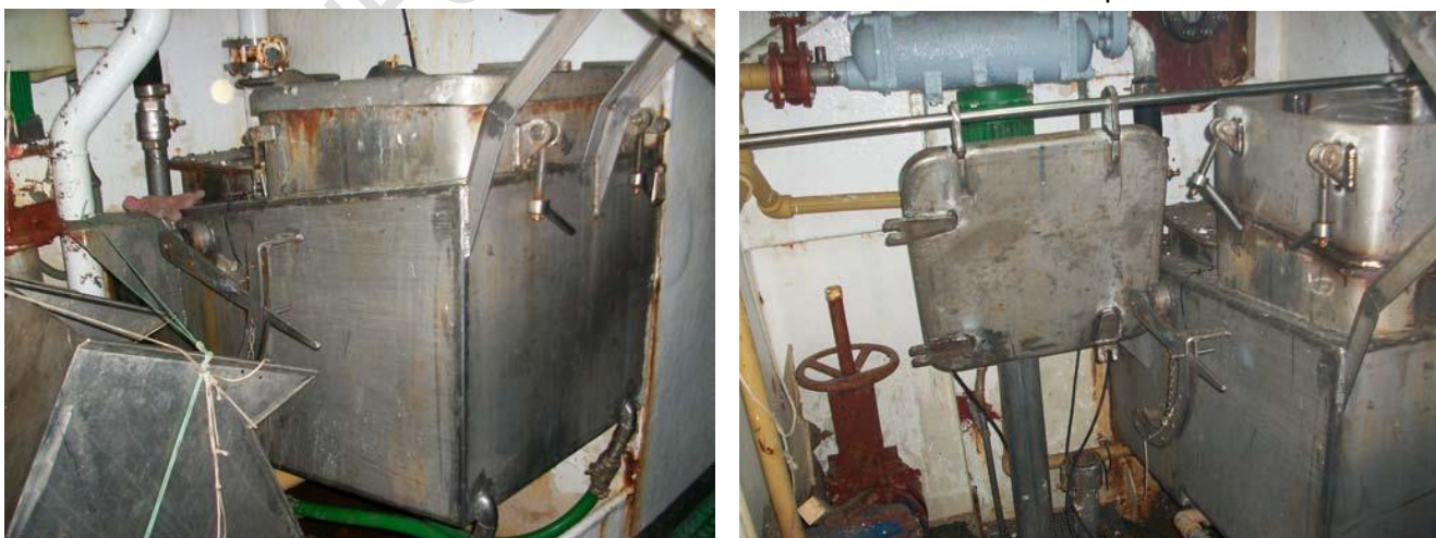
Figura 13. Tolva de desperdicios, antes (izq) y después (dcha) (fuente: NODOSA)
