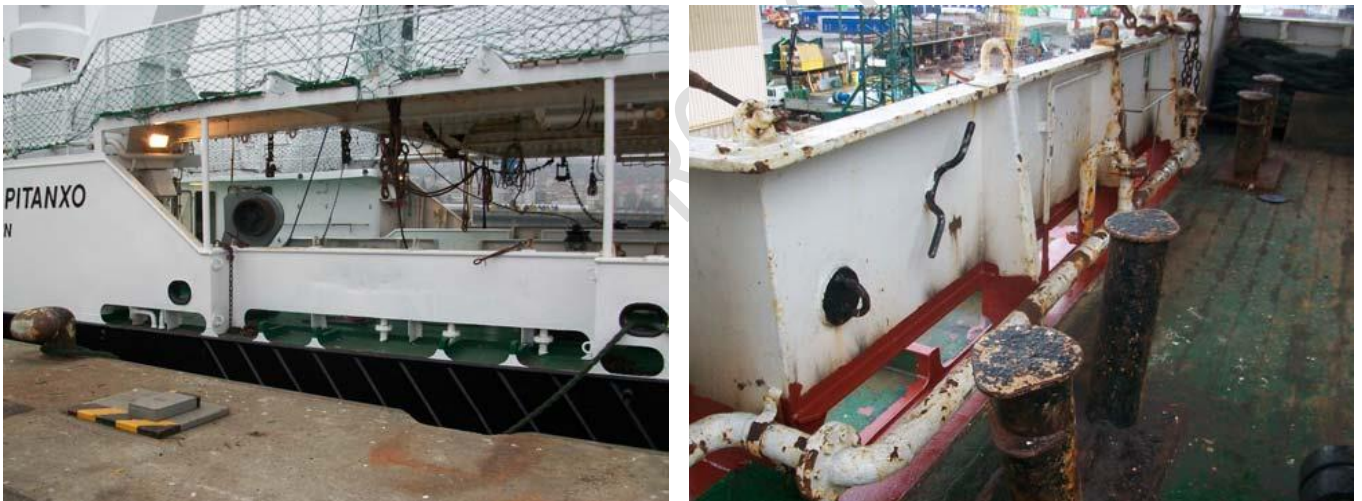
Figura 15. Nuevas falucheras para desague de la cubierta principal (fuente: NODOSA)
